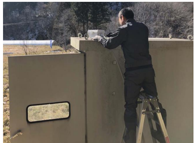
写真 2. キュービクル屋根上への通信アンテナ設置
